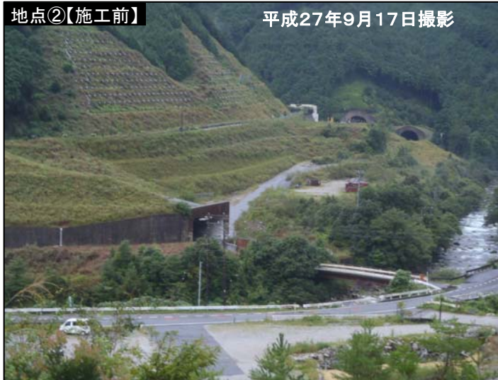
[ 工事進捗状況: 地点② ] 尾鷲南IC付近を望む
